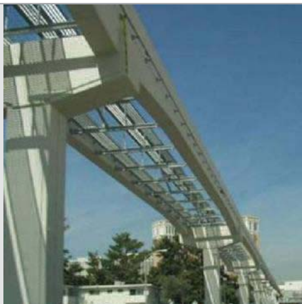
Foto 6.1.1-7 – Sistema de Monotrilho de Las Vegas (detalhe da passarela de segurança)
