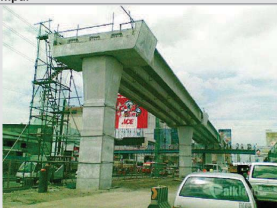
Foto 6.1.1-3 – Sistema de VLT elevado em construção nas Filipinas
